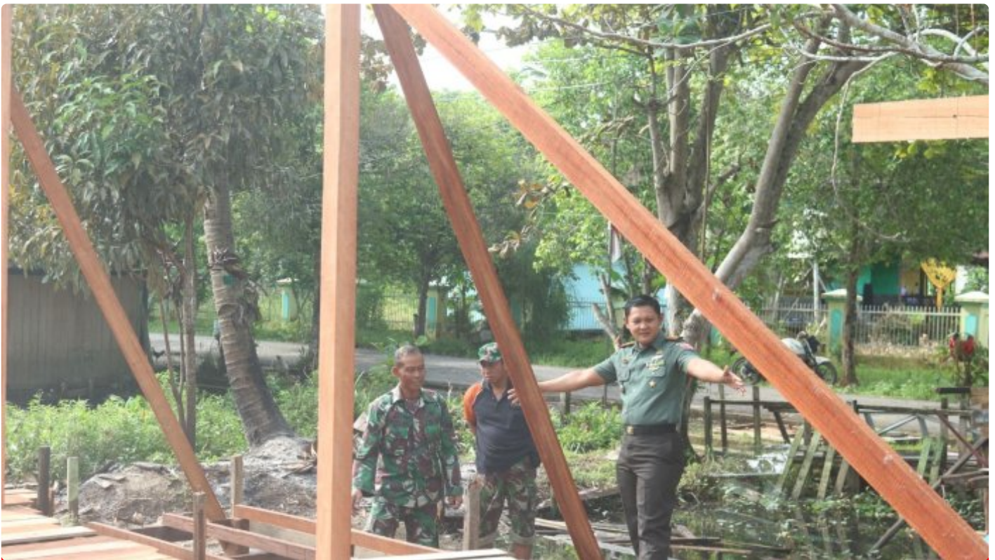
Dandim 1001/HSU-BLG Tinjau Pembangunan Rumah Dinas Prajurit Kodim
